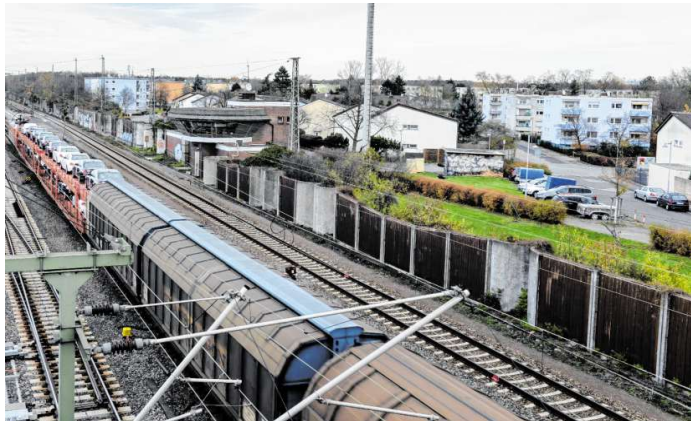
Die Bahnlinie führt direkt an Wohngebieten entlang – Bild von der Riedbahn im Bereich Gartenstadt. BILD: RITTELMANN
